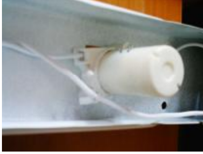
Resim 4.24: Starter takılması
