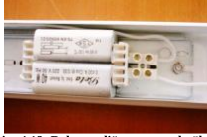
Resim 4.18: Balastın diğer ucunun bağlantısı
