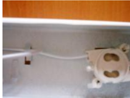
Resim 4.20: Starter soketi bağlantısı
