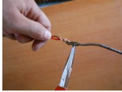
Resim 2.11: Kablonun kılavuza tutturulması
