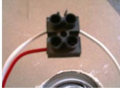
Resim 3.14: Armatürün bir ucuna bağlantı
