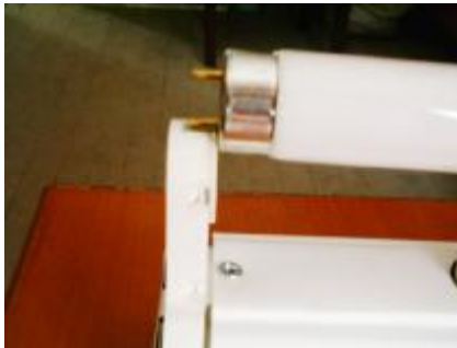
Resim 4.26: Floresan ampulün sokete takılması
