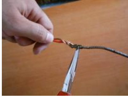
Resim 1.39: Kablonun kılavuza düğümlemesi
