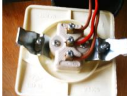
Resim 1.41: Kabloların vaviyen anahtara tutturulması
