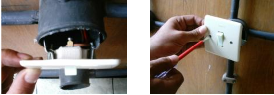
Resim 1.42: Anahtarın kasaya tutturulması
