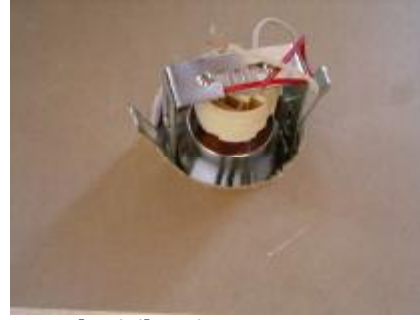
Resim 3.11: Armatürün yerleştirilmesi
