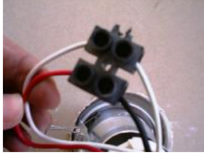
Resim 3.15: Armatüre nötr kablosunun bağlanması
