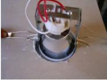
Resim 3.11: Armatürün yerleştirilmesi
