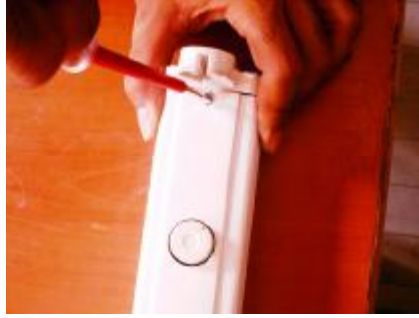
Resim 4.23: Armatürün kapatılması
