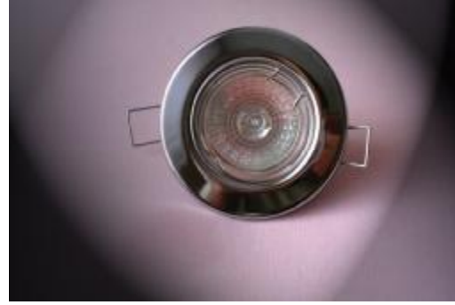
Resim 3.6: Kartonpiyer veya alçıpana monte edilen dekoratif armatür
