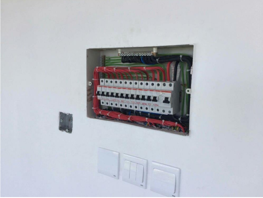
Şekil-2: 16. Tesisat Yönetmeliğine göre düzenlenmiş pano
