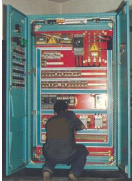
Resim 3.4: Kumanda panosu son kontrollerini yapan teknisyen
