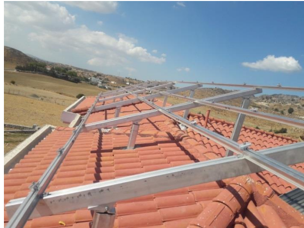
Alüminyum Sigma (H) profil ve kenar kelepçeler
